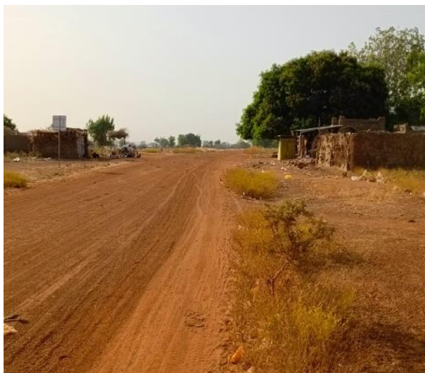
Photo 1: Vue de la traversée de Mangangou
